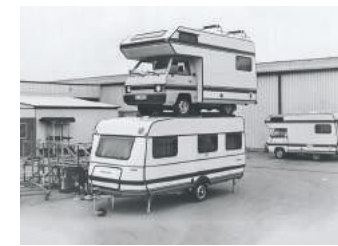
De innovatieve PUAL-opbouw wordt ontwikkeld en bewijst zijn stabiliteit.
